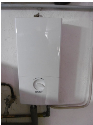
De 21 kW grote elektrische doorstomer voor warm tapwater.
